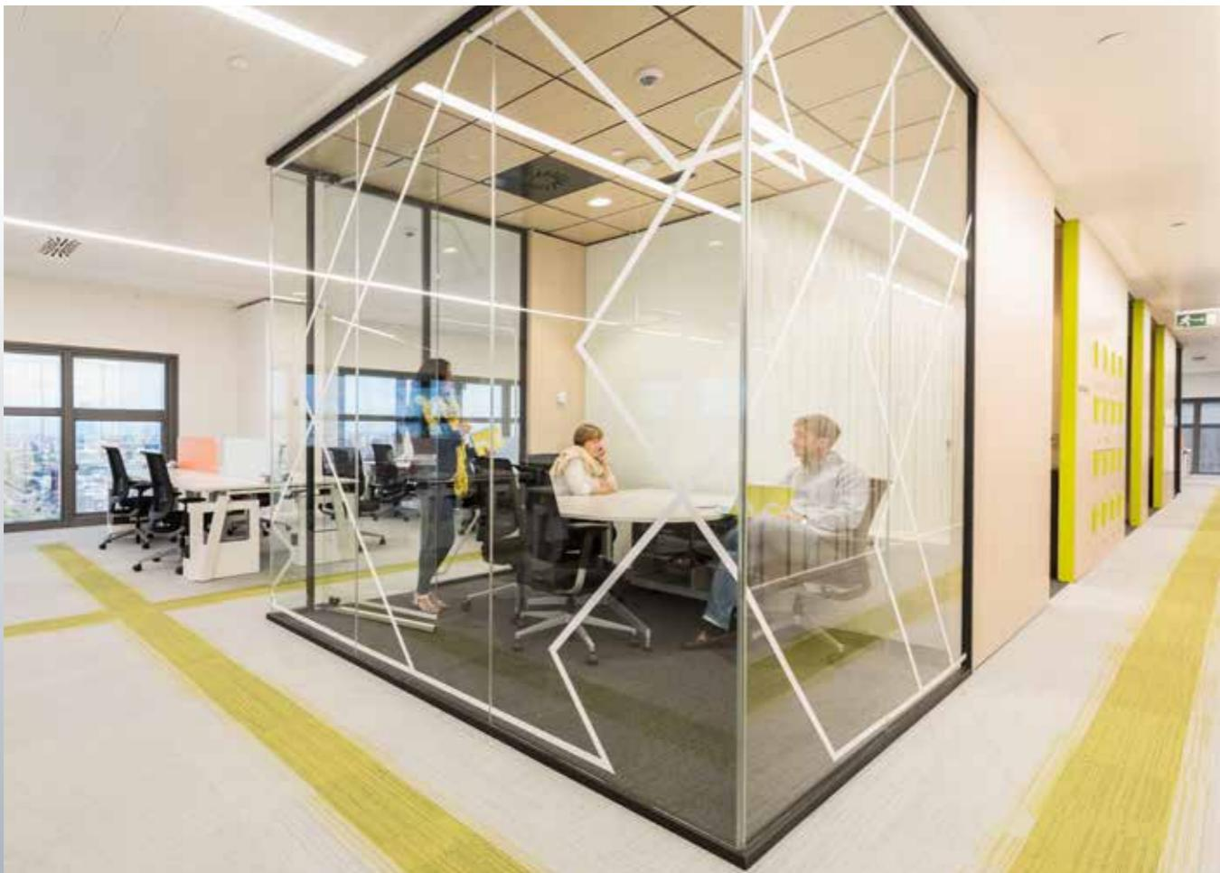
En la junta entre cristales se coloca un policarbonato transparente que asegura la resistencia de la mampara sin interrumpir la superficie acristalada y garantizando el máximo nivel de transparencia.
