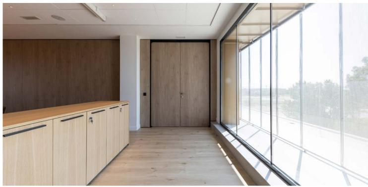
En colaboración con el Estudi Isern Associats, ARLEX a instalado 100m2 de mampara MA7 de doble vidrio para la planta de dirección, 125m² de mampara MA6 de vidrio simple para la planta operativa y 145m2 de mampara ciega MA7 de doble panel en diferentes acabados, roble y gris Cachemir.
